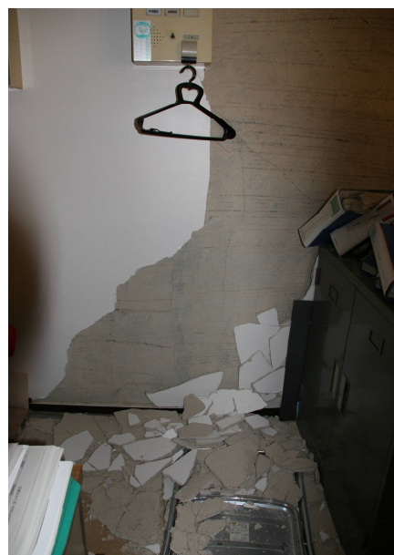
壁の崩落(庁舎)
