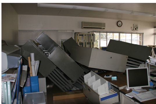
ロッカー等の倒壊(分庁舎)
