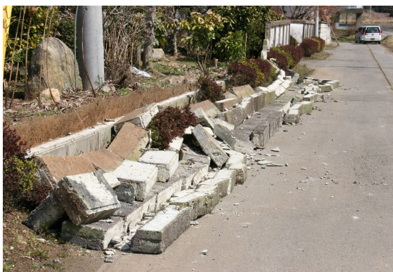
市内各所でみられた塀の倒壊
