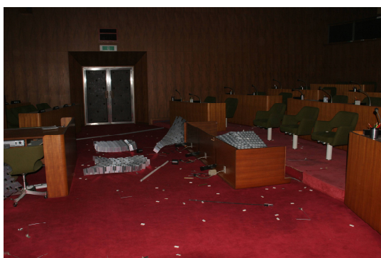
議場の天井落下
