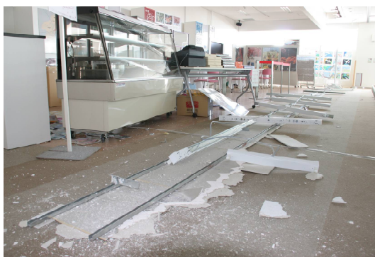
茨城空港の天井落下
