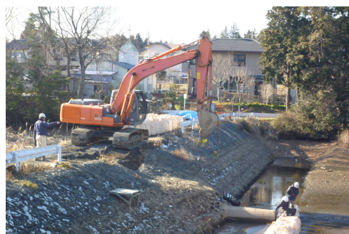
ため池の護岸改修工事
