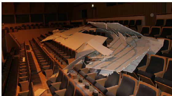
文化センターの天井落下
