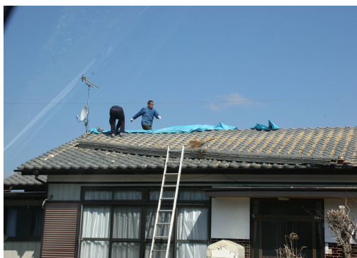
屋根の修復作業
