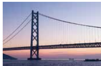
明石海峡大橋
