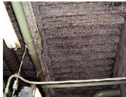
石綿含有スレート波板(屋根・外壁)
