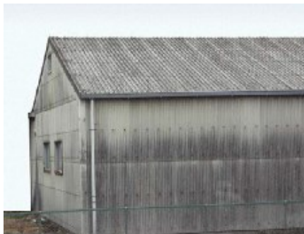
石綿含有吹付けロックウール
