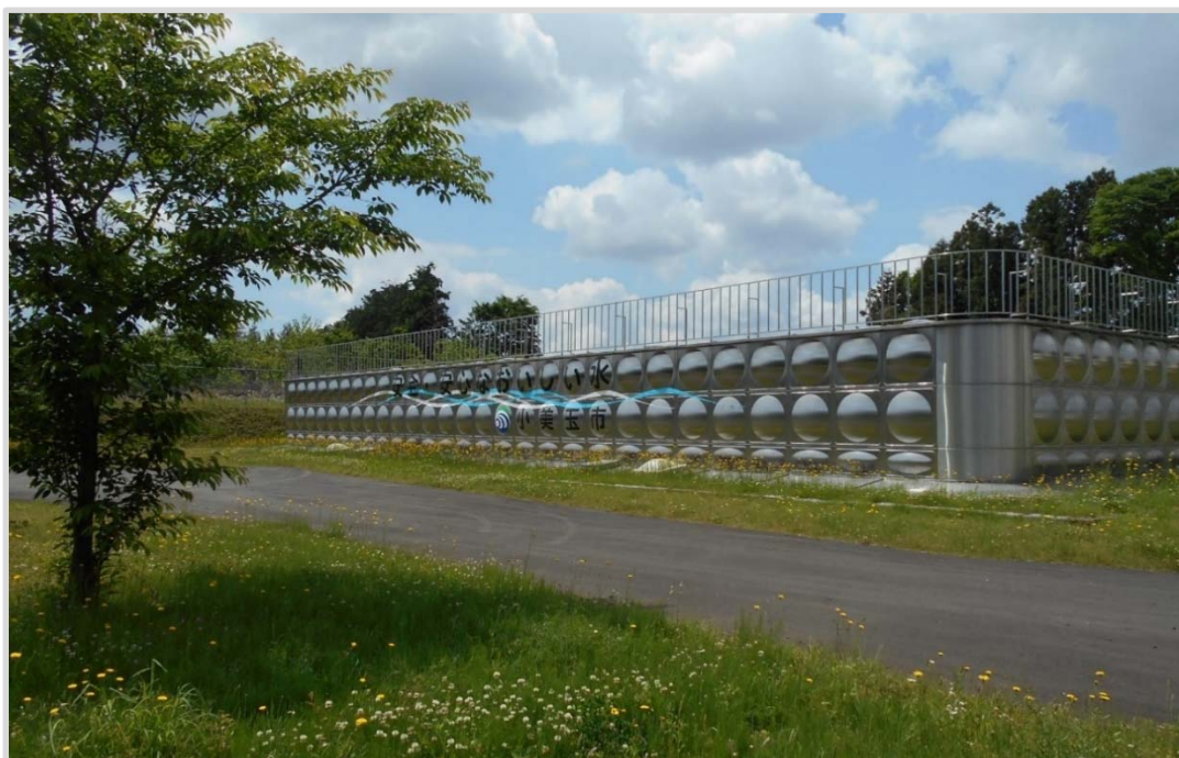
美野里浄水場 配水池No2
