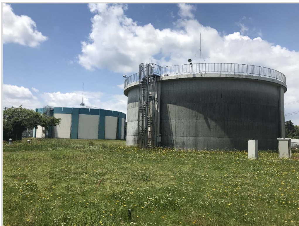
小川浄水場 配水池
