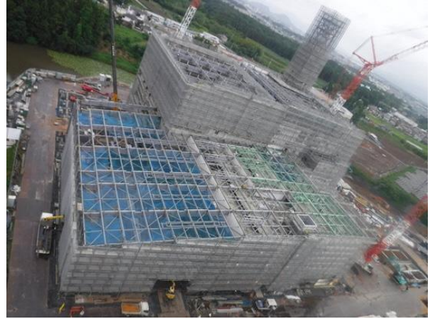
(工事状況 6/30時点 進捗率75.2%)
